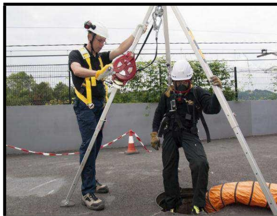
Utilización de un equipo de protección respiratoria para realizar la entrada en un pozo
