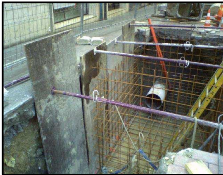
Entibación con planchas de metal
