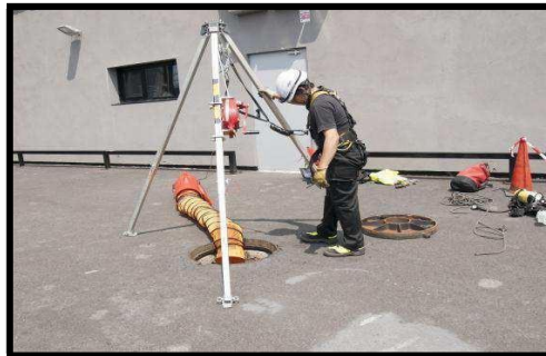
Vigilante en la boca del recinto confinado
