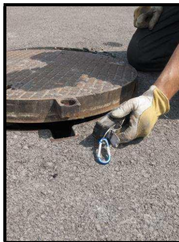
Semiapertura de un recinto confinado
