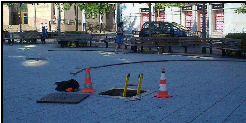
Recinto confinado deficientemente señalizado
