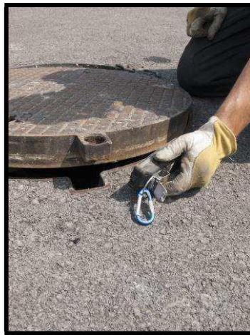
Semiapertura de un recinto confinado
