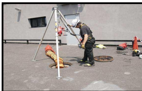
Vigilante en la boca del recinto confinado
