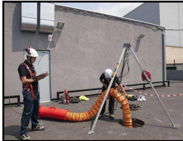
Instalación de un sistema de ventilación
