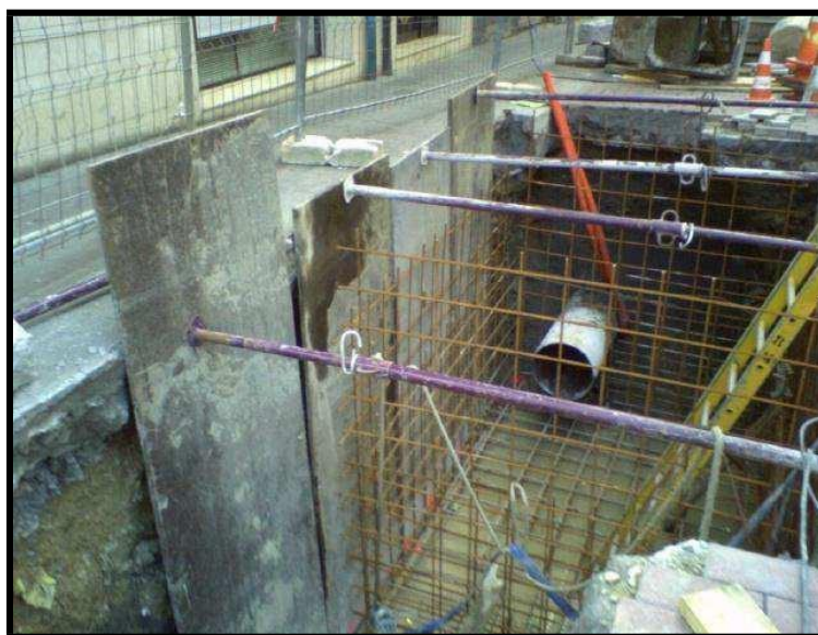
Entibación con planchas de metal
