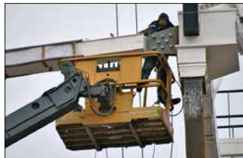
Figura 19. Operario subido sobre las barandillas.
