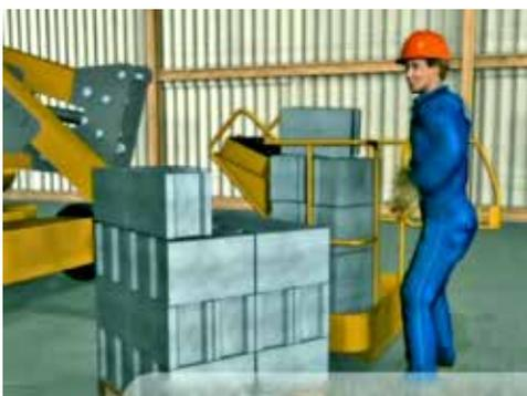
Figura 17. Plataforma de trabajo sobrecargada.
