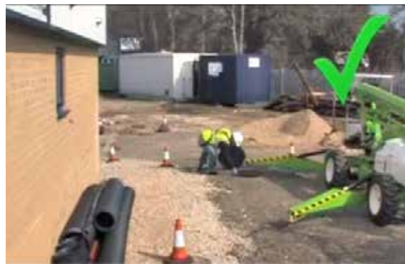
Figura 23. Evaluación previa de las condiciones de terreno.
