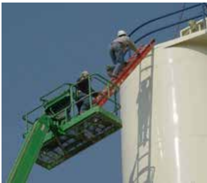
Figura 10. Acceso a una estructura utilizando medios auxiliares
